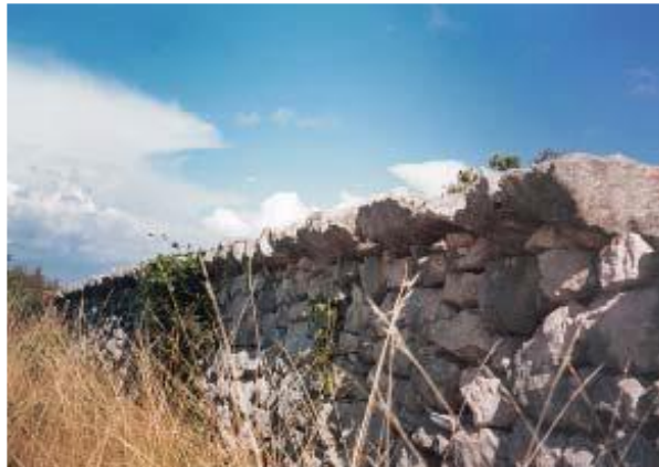
Slika 8. Zid sa tjemanim kamenim pločama 3
