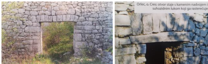
Slike 36.-37. Plitki („segmentalni“) luk na granici popuštanja (lijevo) 7 ; Otvor stajale s kamenim nadvojem i suhozidnim lukom koji ga rasterećuje - Orlec na otoku Cresu (desno) 7
