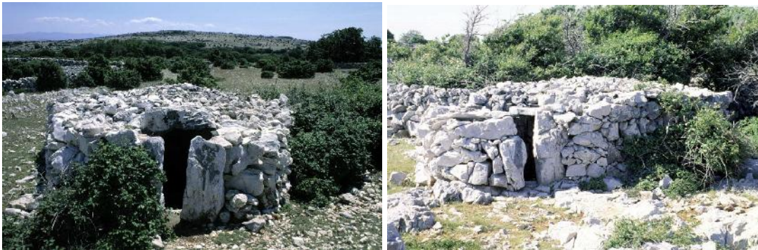
Slike 52.-53. Bunar Semjuni ima prekrasnu škalicu od dva monolita, a iznutra ne samo jednu nego dvije prostorije s vodom, spojene kratkim tunelom (lijevo); Bunar Bunar Navrh Vala (desno) 21
