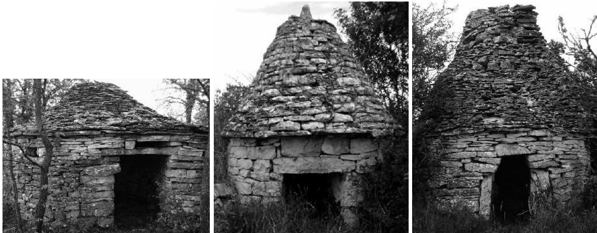
Slike 23.-25. Žminj, kažûn s plitkom kupolom (lijevo) 8 ; Žminj, kažûn s visokom kupolom (sredina) 8 ; Kanfanar, kažûn-vidikovac (desno) 8
