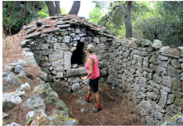
Slika 21. Krušna peć u suhozidu na Komiži (RH) 11
