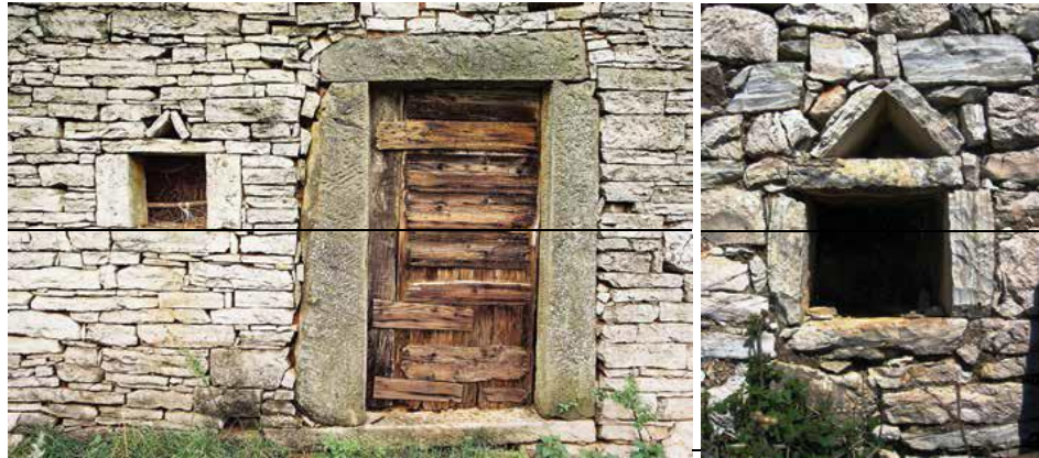
Slike 32.-33. Neobičan oteretni luk (kamen) nad vratima u Ostrogašici kod Uneši (lijevo); Detalj niše u vanjskom zidu kamene kuće (desno) 9
