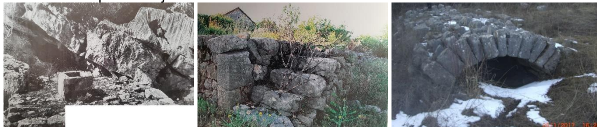
Slike 53.-55. Čatrnja u Plasama (lijevo); 8 Bubalova čatrnja u Hardomilju, Ljubuški (desno); 8 Suhozidni ćemer na čatrnji u Raškom polju, Grude (lijevo; foto: Frano Oreč);
