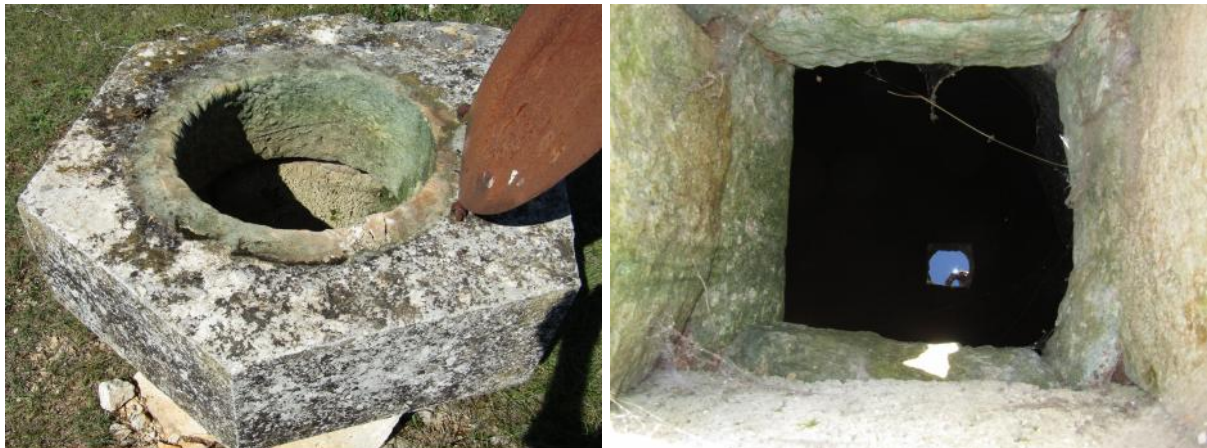
Slike 42.-43. Šesterokutna kamena kruna stare šatrnje od kamena miljevine u Kovačima, u blizini ceste Posušje-Imotski (lijevo), sa pogledom u unutrašnjost (desno) (foto: Krešimir Šaravanja)
