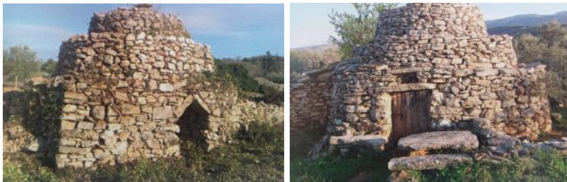
Slike 38.-39. Bunje u okolici Vodoca često imaju ulaze od dvije strane i ploče pod kutom, kasnije poznat kao „trozglojni luk“ (lijevo) 7 ; Hvarski trimi imaju ovakve nadvoje. Malim otvorom rasterećuje se donja ploča. A u trim prodire i nešto svjetla (desno) 7
