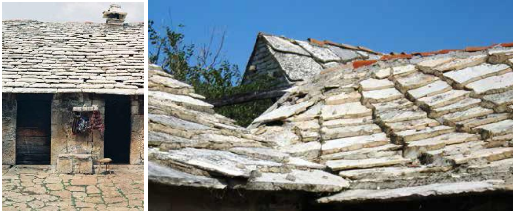
Slike 65.-66. Detalji krovova od kamenih ploča: kuća u Šibenskom zaleđu (lijevo); Kuća u Zadarskom zaleđu (desno) 19
