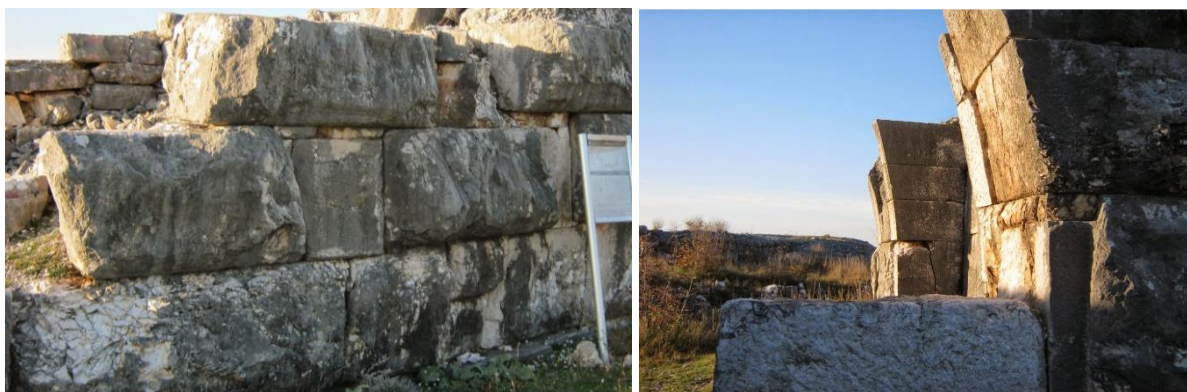
Slike 8.-9. Pogled izbliza na monumentalnost obrađenih i složenih kamenih blokova u Ošanićima, Stolac (lijevo); Zanimljivi detalj lučnog nadsvoda u bočnoj strani glavnog ulaza (foto: G. Glamuzina) 18
