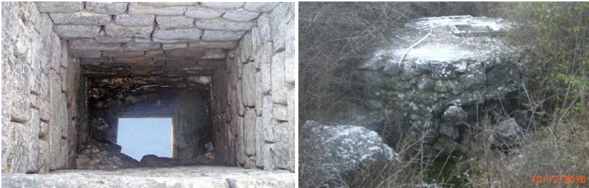
Slike 44.-45. Zdenac Studenac (lijevo; foto: Ivan Dugandži ); Tomin bunar obložen suhozidom u Ore ima, kod Posušja (desno; foto: Frano Ore )
