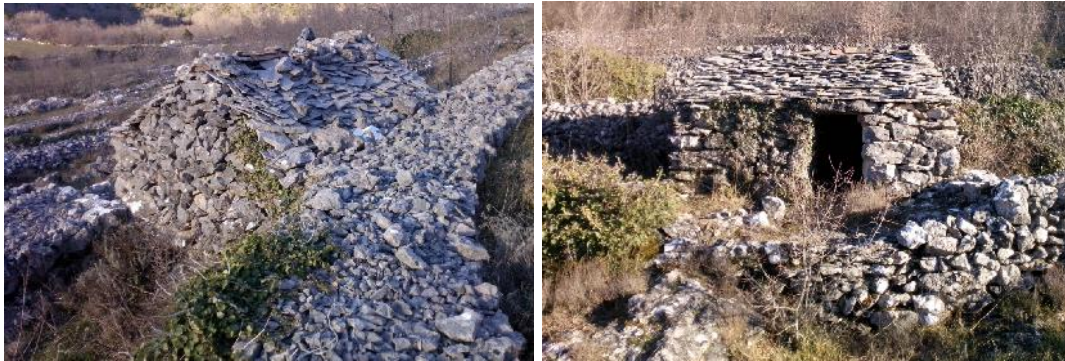
Slike 28.-29. Kamena kućica u selu Brotnice u Konavoskim brdima, Hrvatska 11 ; Pogled na spoj kućica na suhozid (lijevo) i pogled na ulazni dio (desno) 11
