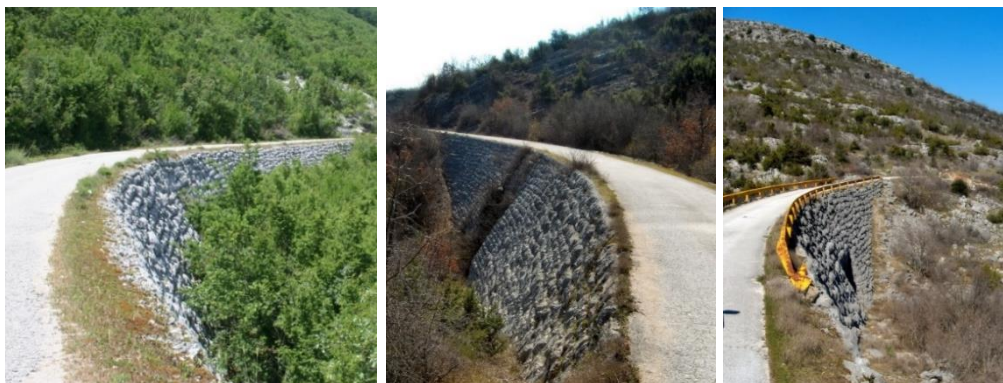
Slike 21.-23. Podzidi željezničke pruge: kraj Diklića (lijevo) i između Diklića i Poljica, Trebinje (sredina); Na nekim dijelovima je prenamijenjena u cestovni promet radi povezivanja gornjih sela od Popovog polja ka Trebinju; Salaši, podzid i propust (desno) (foto: Ivan Đurović) 26
