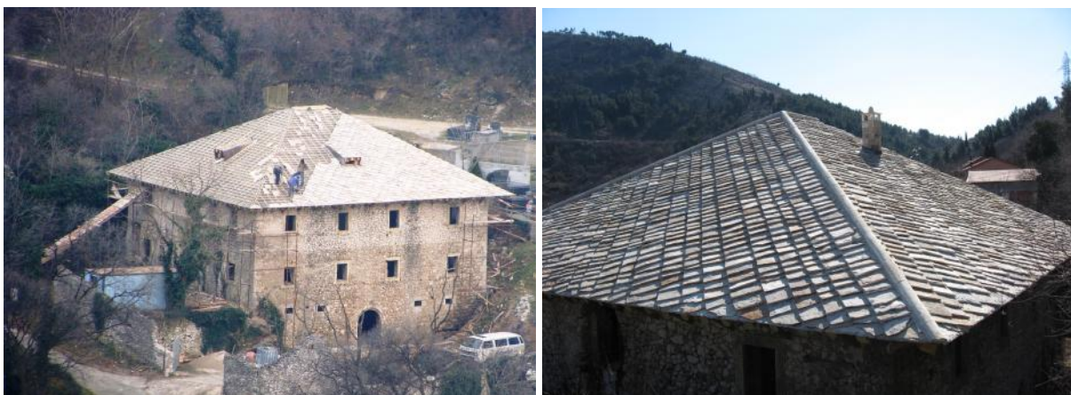
Slike 63.-64. Obnova četverostrešnog krova sa kamenim pločama na Biskupskoj rezidenciji u Vukodolu, Mostar (lijevo), sa detaljom obnovljenog krova (desno) (foto: prof. Mladen Glibi)
