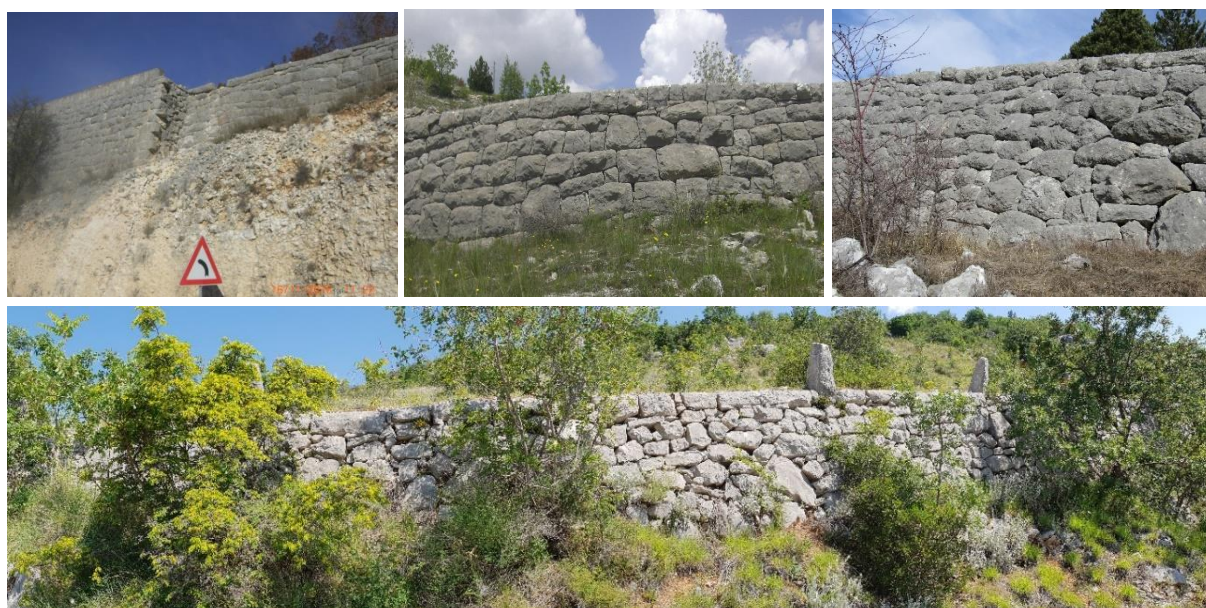
Slike 26.-29. Suhozidni podzidi nekih od starih cesta: Posušje-Imotski, Posušje-Rakitno, Tribistovo-Posušje (gore); Suhozidni podzid sa kamenim kolobranima stare austrijske ceste Gorica-Posušje u Zavali-Gorica, Grude (dolje) (foto: F. Oreč i K. Šaravanja)
