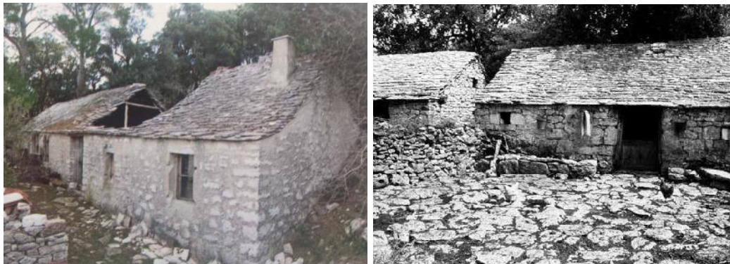
Slike 30.-31. Zaselak Dragodid na otoku Visu (lijevo) 7 ; Graditeljstvo u Zadarskom i Šibenskom zaleđu - elementarne prizemnice često opasane visokim zidom 14
