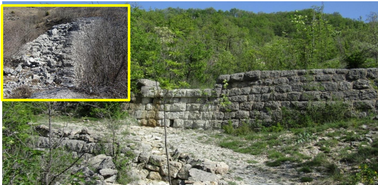
Slike 61.-62. Protubujične suhozidne pregrade u donjoj Podbiljoj i u Sopču, Posušje, nizvodna strana (gornji lijevi kut) (foto: K. Šaravanja)
