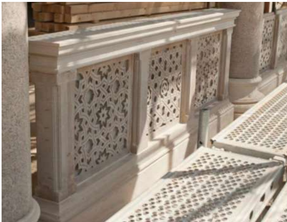
Slika 21. Dekorativni element ograde na Vijećnici u Sarajevu urađen od sedrastog krečnjaka sa ležišta Mošćanica (foto HM-Tenax, 2012)
