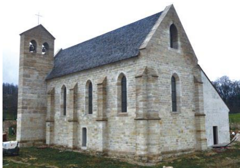
Slika 52. Gora, crkva Uznesenja BDM, pogled s jugoistoka nakon rekonstrukcije (snimio D. Miletić) 10
