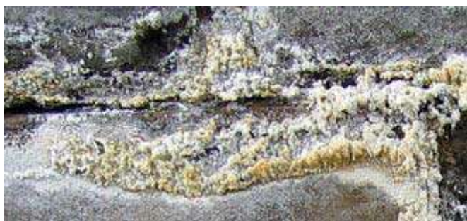
Slika 18: Formiranje soli stvarajući cvjetanje na površini zida od pješčara što se spaja u pukotinama između blokova zida
