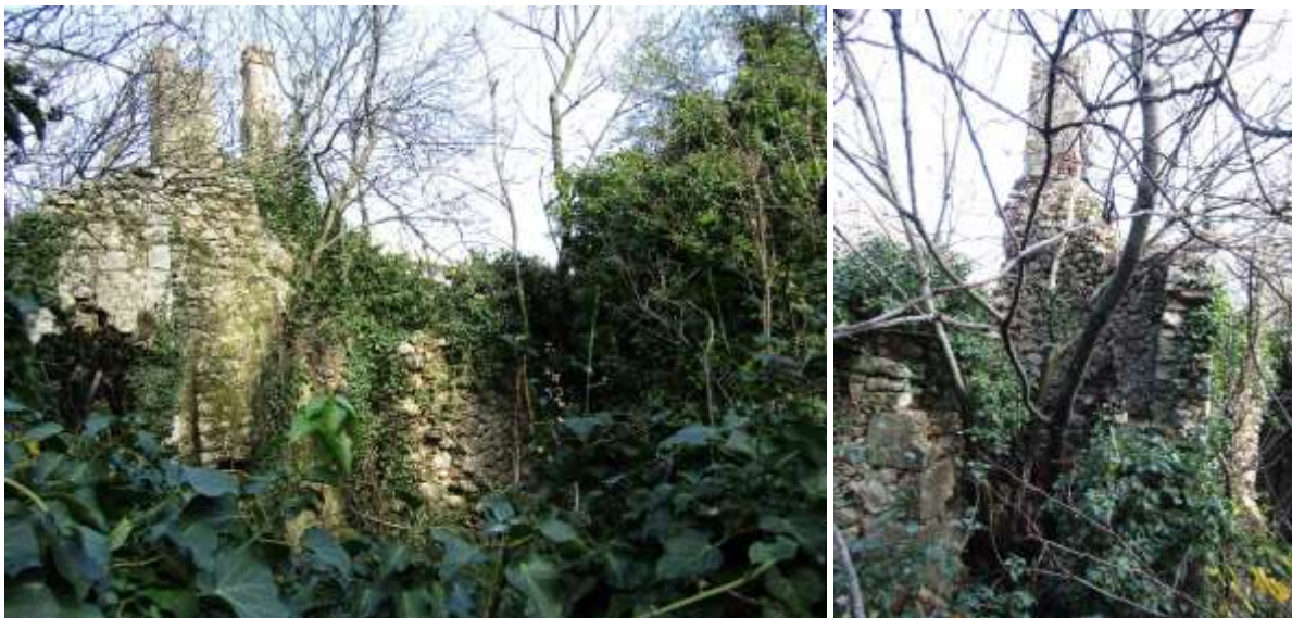
Slike 26.-27. Ostaci pomoćnog objekta gospodarsko-rezidencijalne namjene sa dimnjakom (foto: Krešimir Šaravanja)
