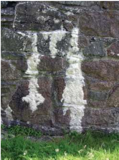
Slika 19: Inkrustacija kalcita povezana s vodom koja se cijedila iz pukotina, na granitu, pješčaru i klesanom škriljcu
