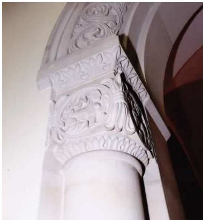
Slika 3. Detalj stuba sa kapitelom i dijelom luka kao dio enterijera Kraljevog dvora na Dedinju urađeni od Bihacita sa ležišta Maskara (foto http://maxixell.com )
