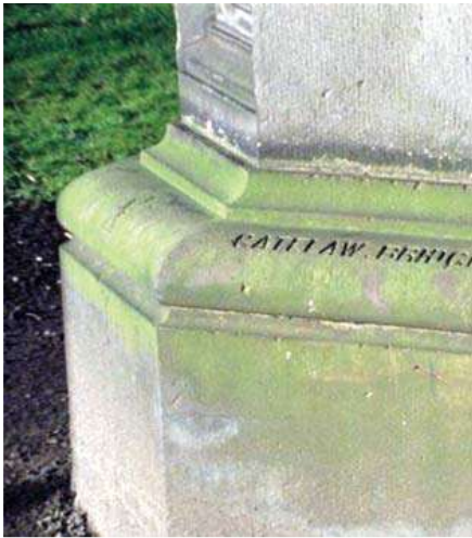
Slika 1: Uobičajena promjena na arhitektonskim oblicima nastala usljed djelovanja algi
