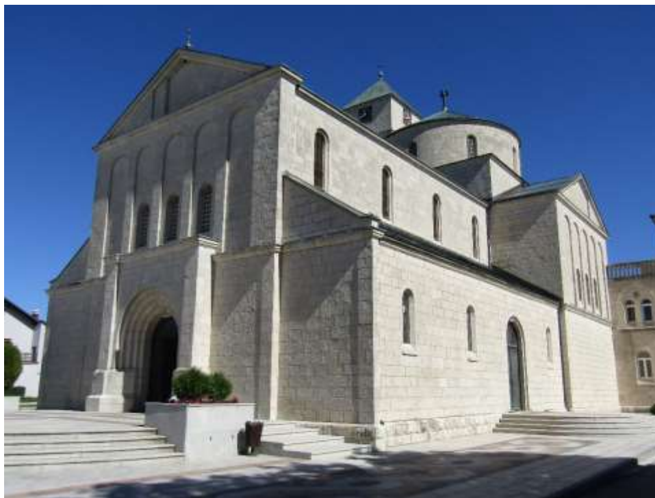
Slika 25. Katolička crkva sa samostanom u Tomislavgradu izgrađena od sedrastog krečnjaka vađenog iz kamenoloma na lokalitetu Kologaj (foto Šaravanja, 2016.)
