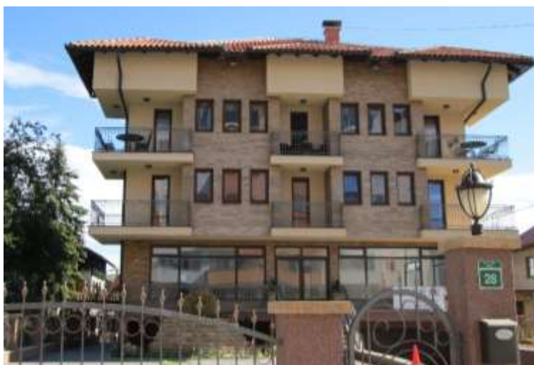
Slika 8. Fasada na stambenom objektu u ulici Blažujki drum na Ilidži obložena bunjom od Plivita (foto Hajdarević, 2015)
