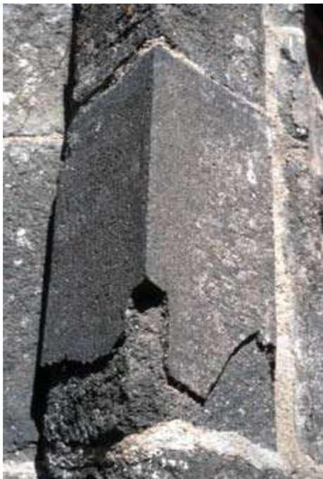
Slika 11: Otpadanje kontura po slojevima do kojeg dolazi na magmatskom kamenom elementu (Kersanton)
