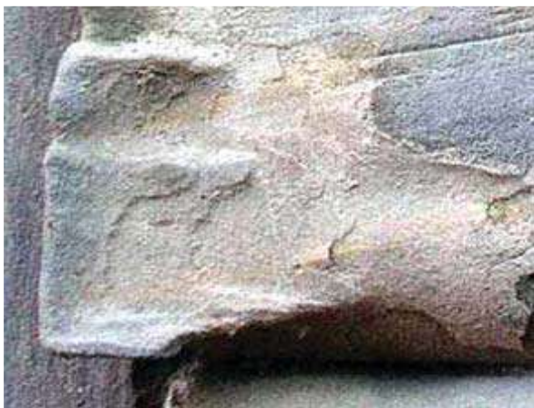
Slika 13: Blok pješčara kontaminiran natrijum hloridom. Kristalizacija soli dovodi do granularnog raspadanja i otpadanja kamena po slojevima. Budući da su slojevi jako tanki, proces degradacije se takođe naziva listanje.
