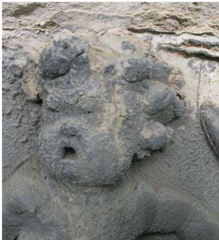
Slika 3: Krečnjački reljef koji pokazuje uznapredovalu dezintegraciju.
