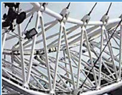
Čelični okvir trokutaste rešetkaste konstrukcije
