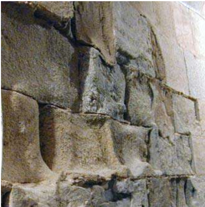
Slika 10: Raspadanje-osipanje u obliku pijeska granita sa grubom zrnastom građom
