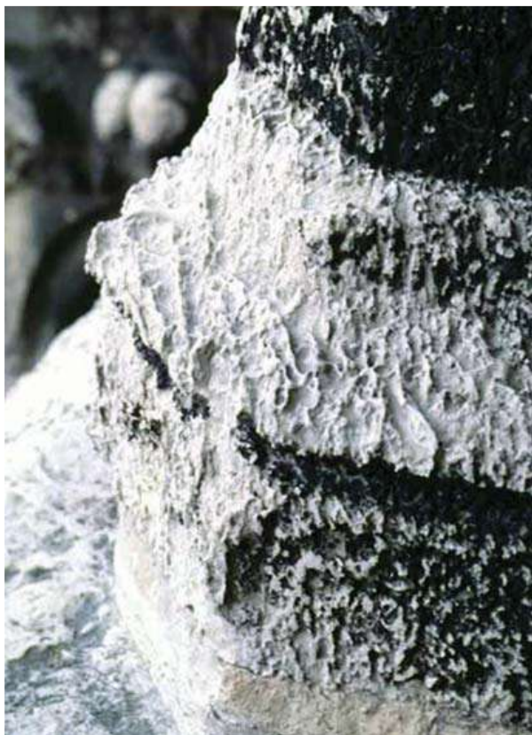
Slika 15: Mikro-raspadanje do kojeg je došlo na osnovi stuba od krede koji je naročito izložen utjecaju vremenskih prilika
