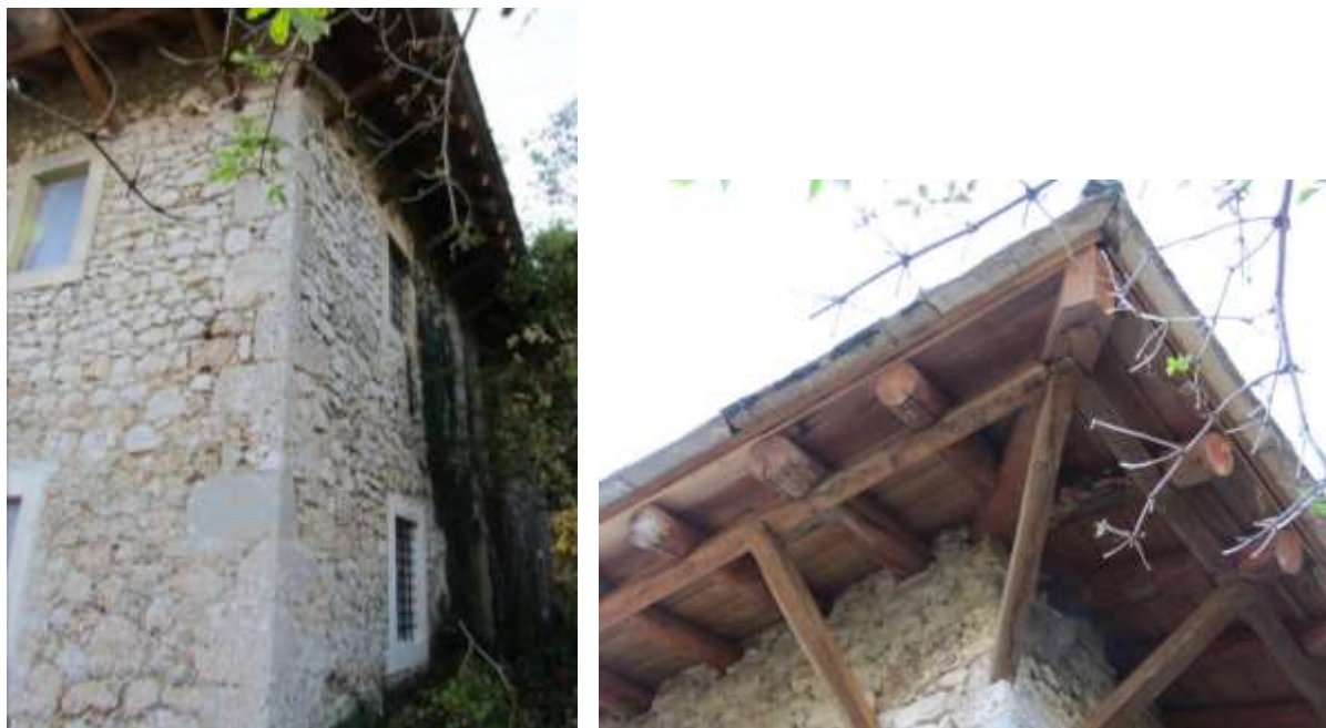
Slike 11.-12. Struktura zidova, građenih od pritesanih kamenih blokova, vidljiva sa vanjske strane, sa uglom zidanim pravilno klesanim kamenim blokovima (Lijevo); Detalj drvene krovne konstrukcije (foto: Krešimir Šaravanja)
