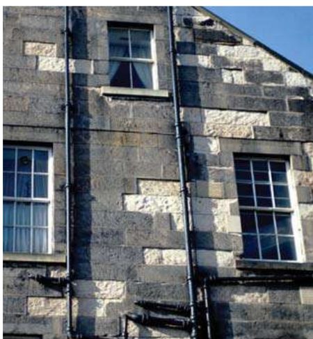
Slika 5: Propadanje zida od pješčara iz razdoblja karbona
