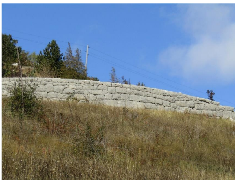
Potporni zid na starom putu Posušje - Rakitno
