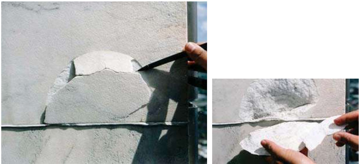
Slika 8: Tipično rasprskavanje na ravnoj mramornoj plohi
