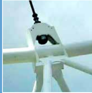
Detalj spoja zatege s unutarnjom tetivom čeličnog okvira
