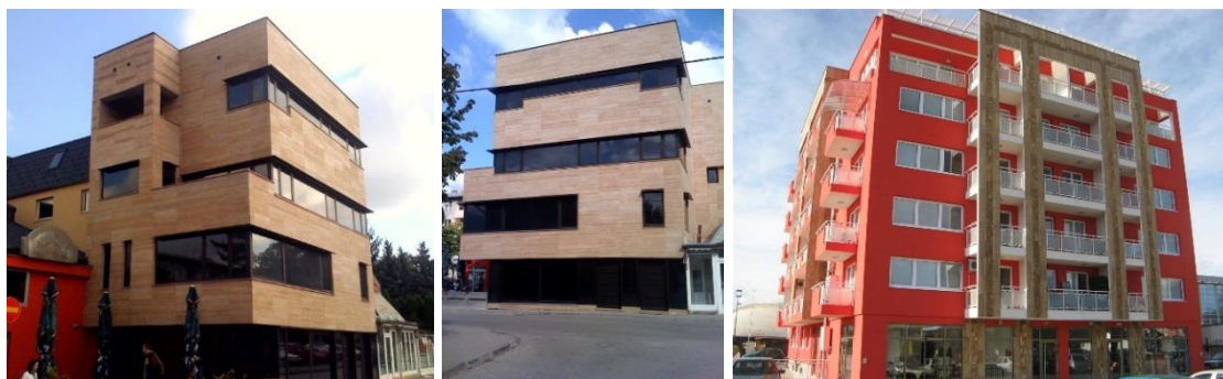
Slike 62.-64. Primjena Plivita za fasade poslovnih građevina 12
