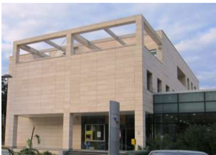
Slika 16. Fasada od miljevine na jednom objektu u Mostaru (foto Hajdarević, 2013)
