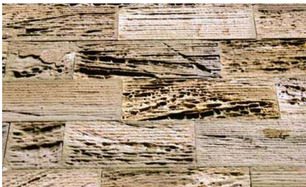
Slika 14: Alveolizacija ovdje nastaje kao šupljine koje ilustruju kombinaciju promjena u vidu saća i linija koje prate prirodne ravnine slojeva pješčara
