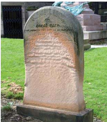
Slika 2: Oštećenje donjeg dijela nadgrobnog spomenika od kamena pješčara rezultira gubitkom vrijednosti
